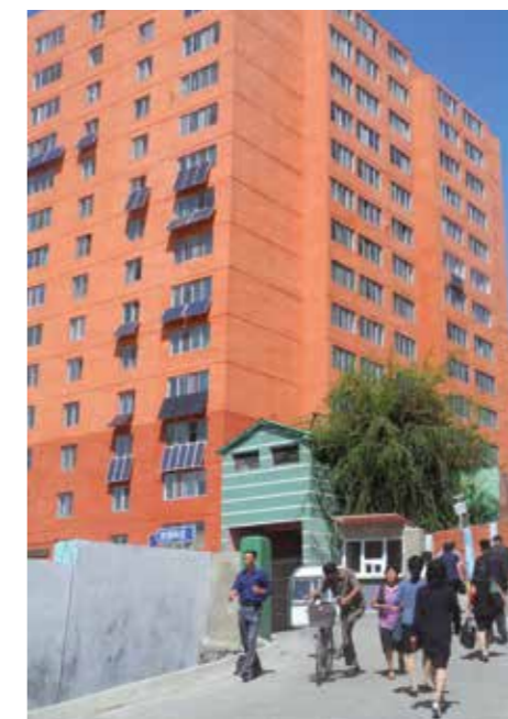
Les panneaux solaires photovoltaïques ont fleuri dans tout le pays
